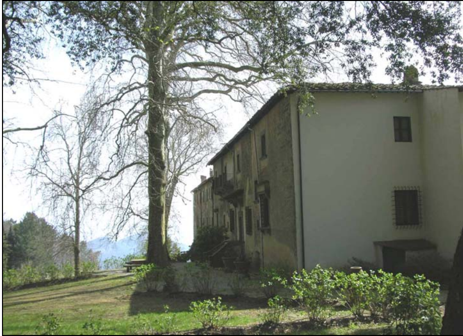
Descrizione: Il fronte laterale della villa. Data: 17/04/2004
