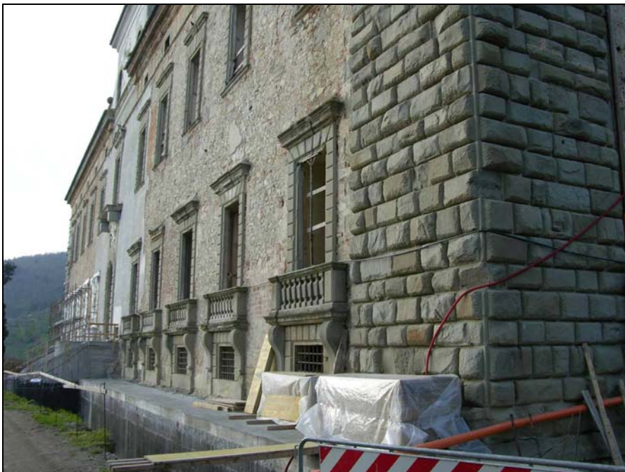
Descrizione: Fronte principale della villa, dettaglio della soluzione d'angolo. Data: 16/04/2006
