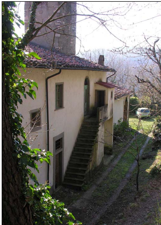
Descrizione: Prospetto laterale con gli edifici attaccati alla chiesa. Data: 07/04/2006
