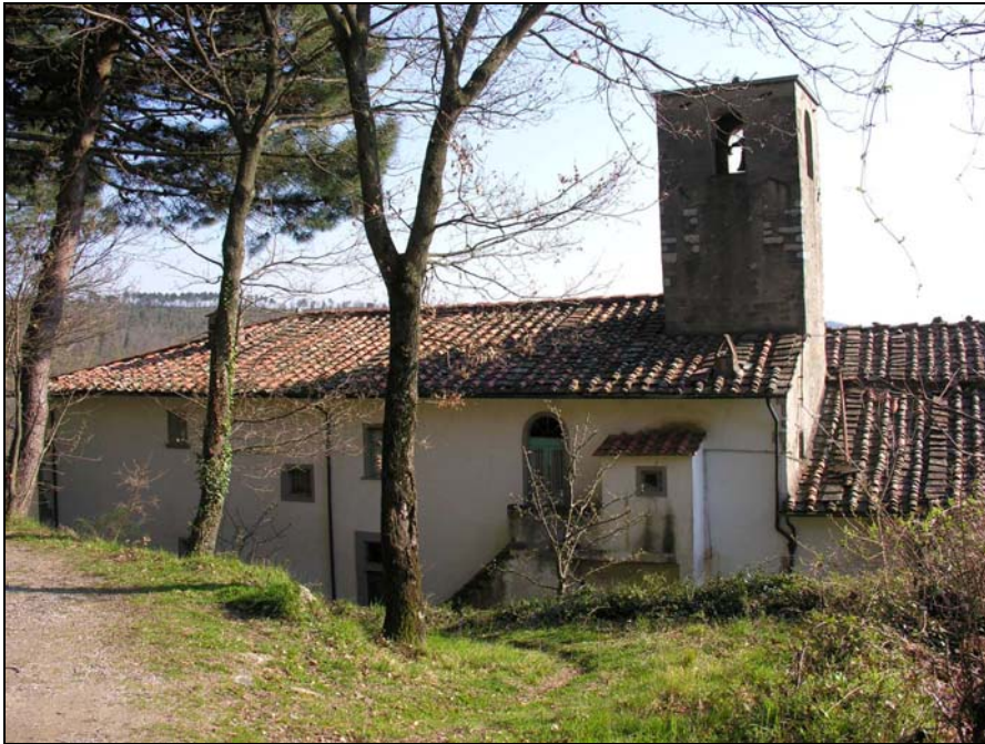
Descrizione: Prospetto laterale con gli edifici attaccati alla chiesa. Data: 07/04/2006
