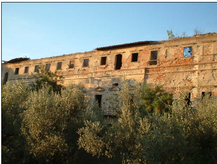
Descrizione: Prospetto della villa che volge verso la piana pratese.
