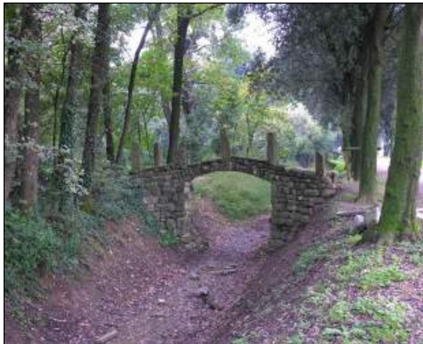
Descrizione: Ponte del complesso delle Cascine. Data: 04/11/2005
