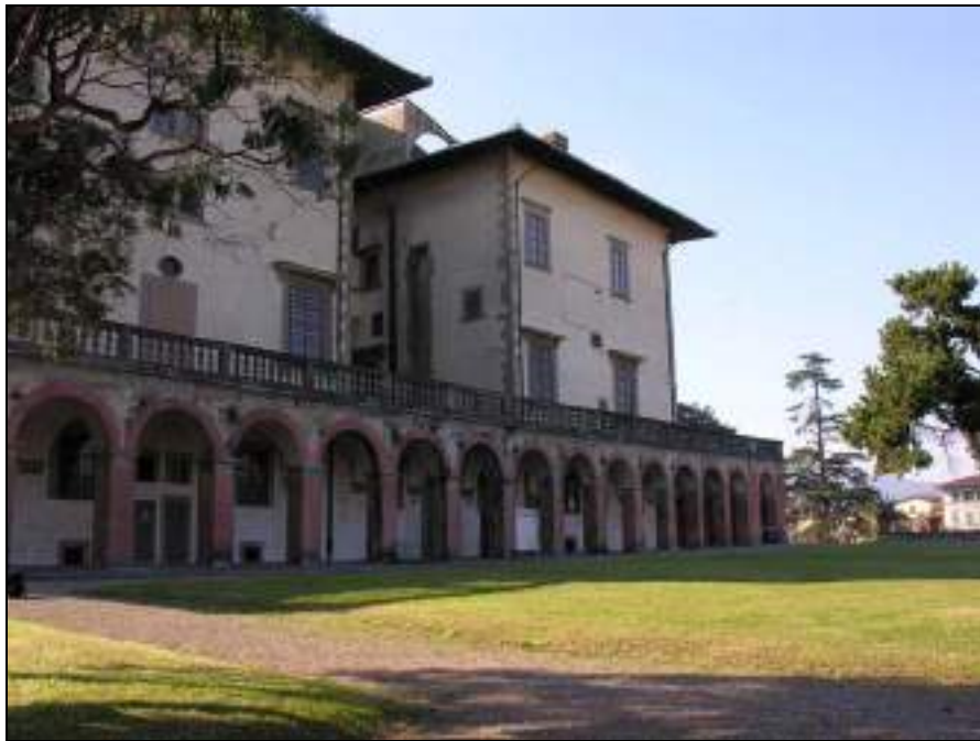
Descrizione: Il lato nord ovest della villa. Data: 14/04/2006
