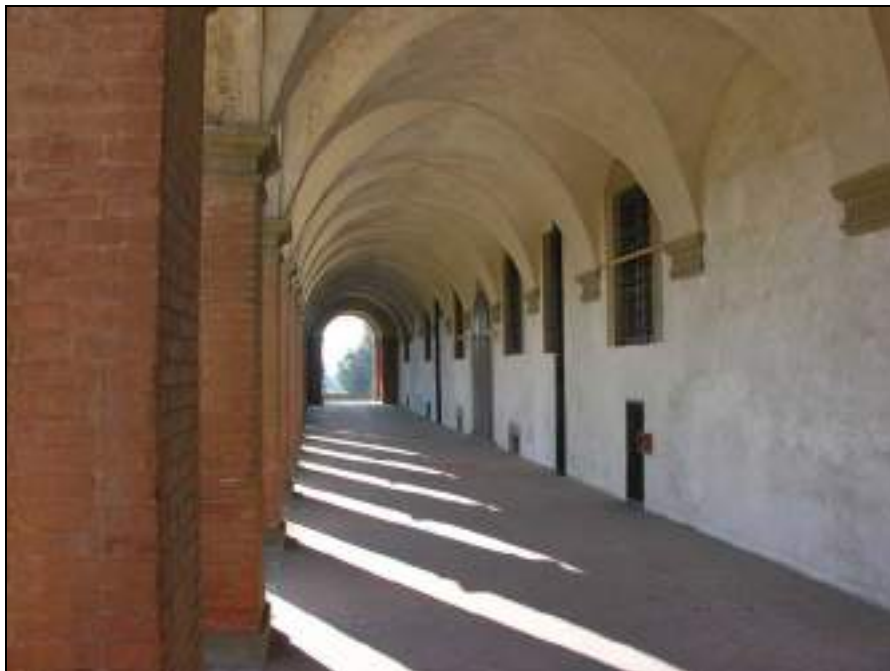
Descrizione: Uno dei corridoi laterali della villa. Data: 14/04/2006
