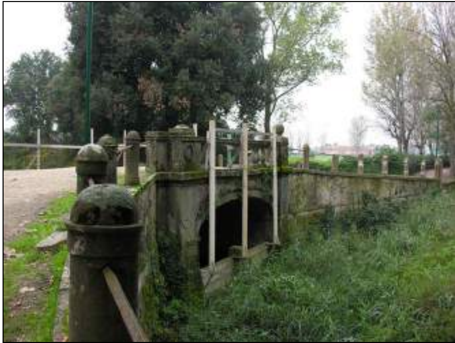
Descrizione: Ponte del complesso delle Cascine. Data: 04/11/2005
