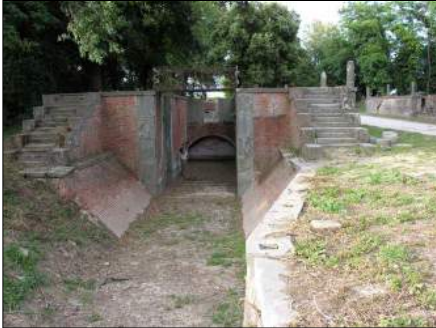
Descrizione: Ponte del complesso delle Cascine. Data: 30/05/2005
